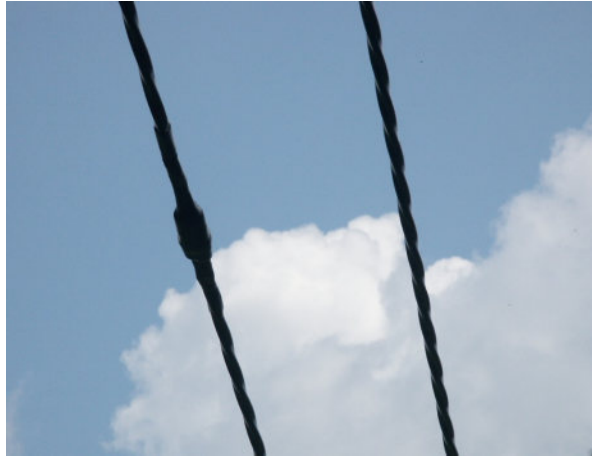
Kabelska spojka v razpetini – kabel AXCES™
